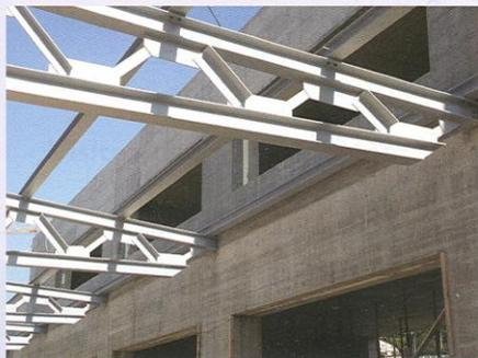
laquelle se trouvent les butoirs d'arrêt des voies. La structure du bâtiment est métallique: charpente de toiture d'une seule portée de 16,59 m sur piliers de façade.
